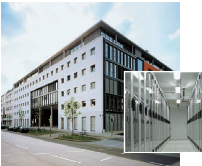
Das 1&1 Rechenzentrum in Karlsruhe
